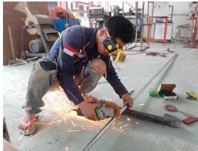
Gambar 17. Pemotongan Material Pipa Galvanis
